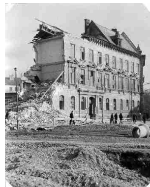
Obr. 11 Takto budova skončila – musela ustúpiť ceste vychádzajúcej z nového mostu a súčasnej budove Ministerstva spravodlivosti.
